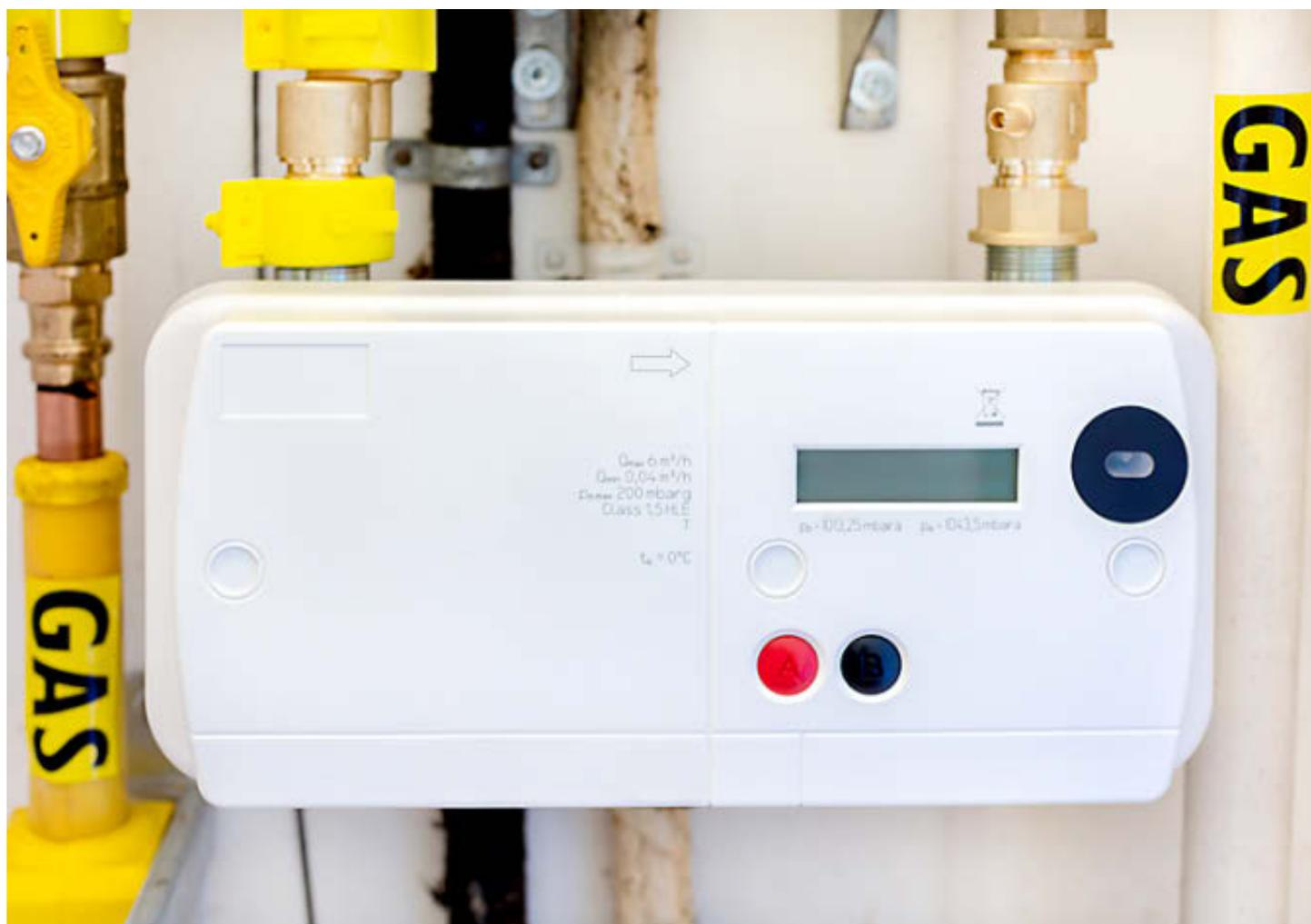
Contador de gas inteligente holandés con conexión inalámbrica al proveedor de energía. iStock
